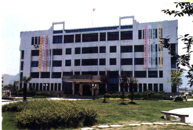
县土地管理局办公大楼
