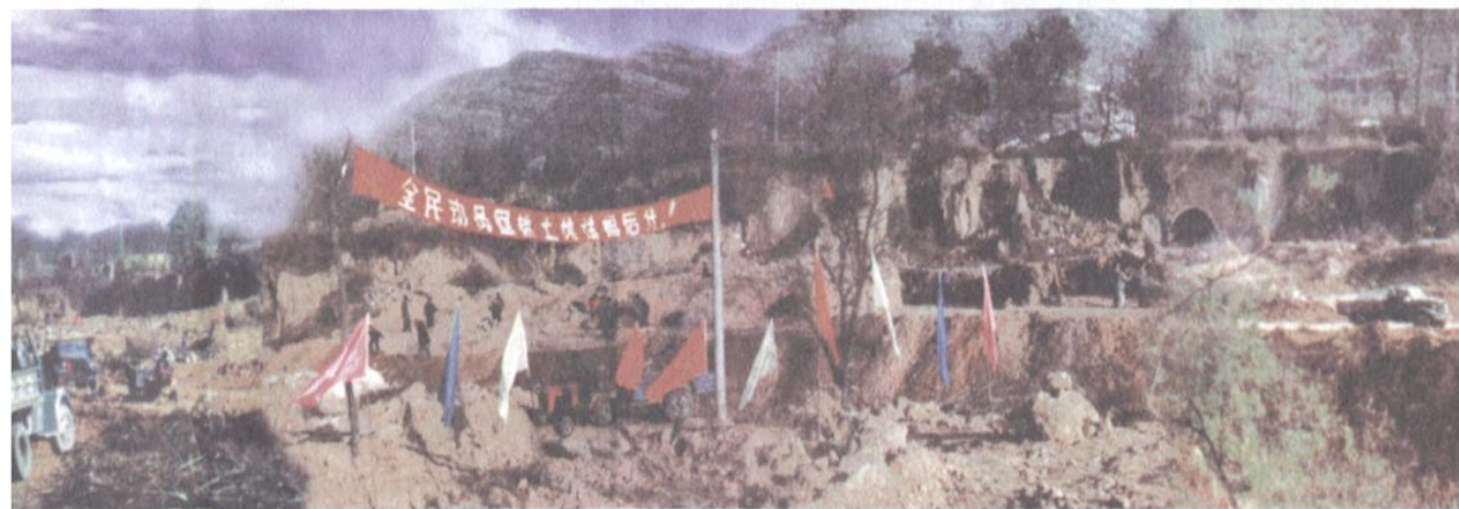
洼村旧址回填情景
