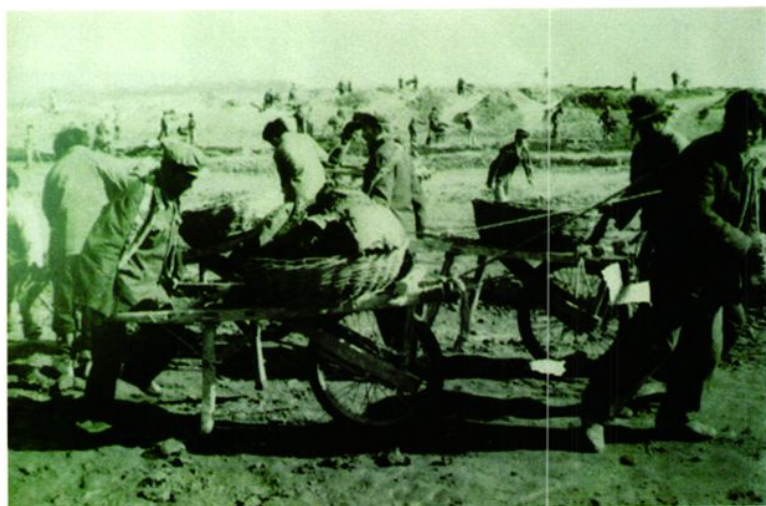
1976 年朱楼民工用手推车开挖河道
