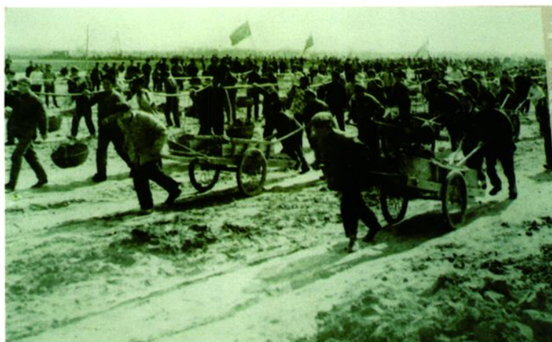
1976 年青春大队民工用平板车开挖河道
