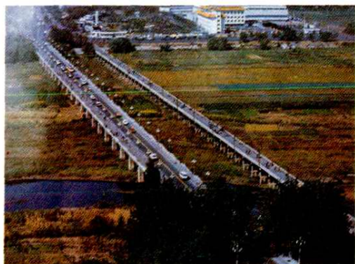
迎泽大桥建于1953年，全长480.5米， 全宽15.4米，设计荷载为60吨
