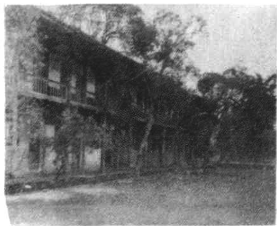
日本式教学楼（1903年建）
