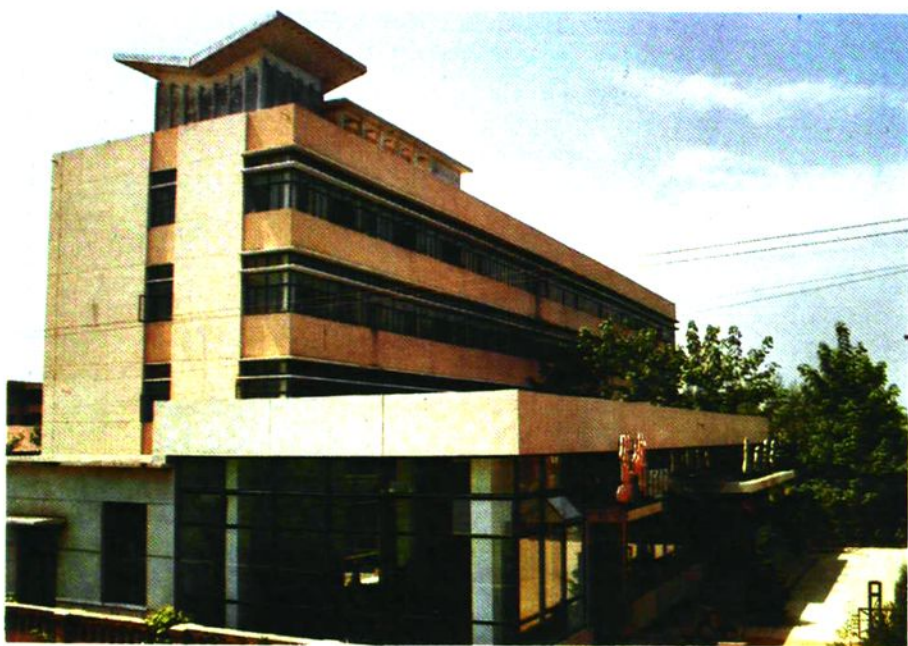
市话三分局、新市区邮电局通信楼(东风西路)
