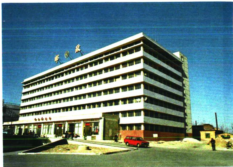
邮政枢纽楼(火车站北侧)
