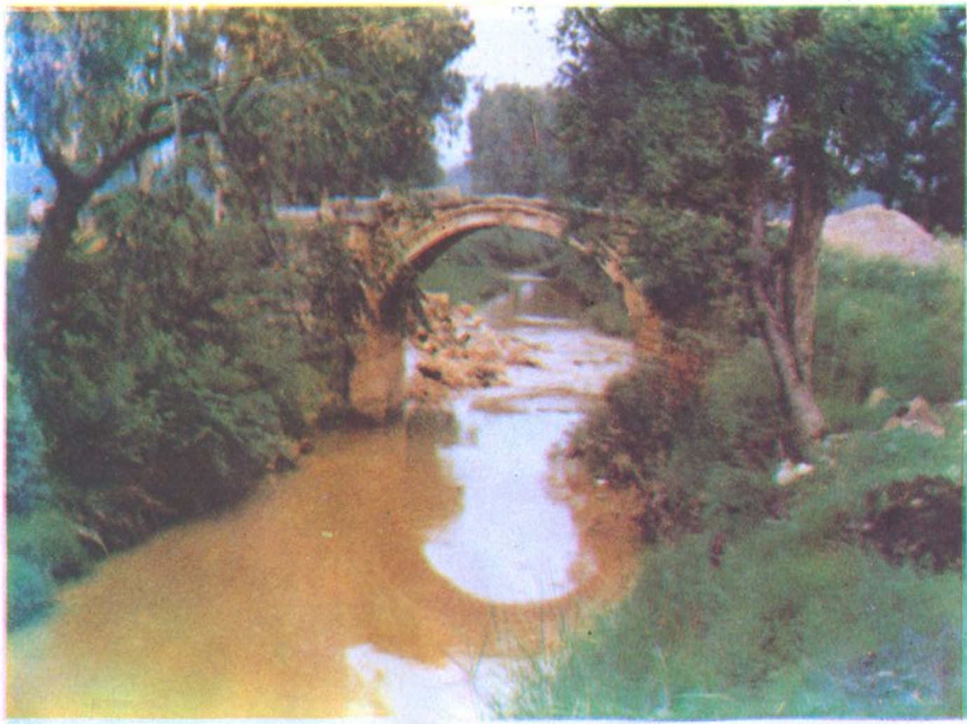
建于明朝万历年间的沙甸石拱桥
