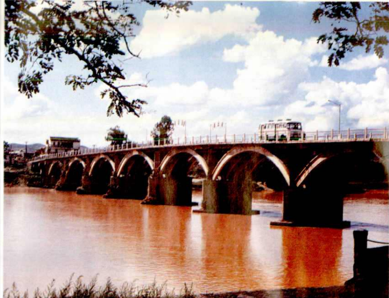
锦江桥（位于丙村镇）
