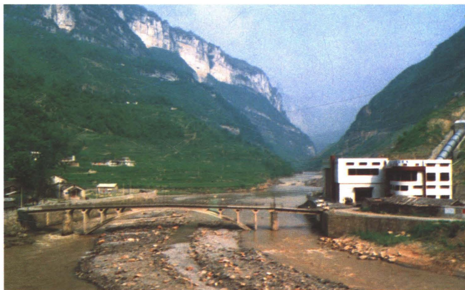
天楼地枕水电站
