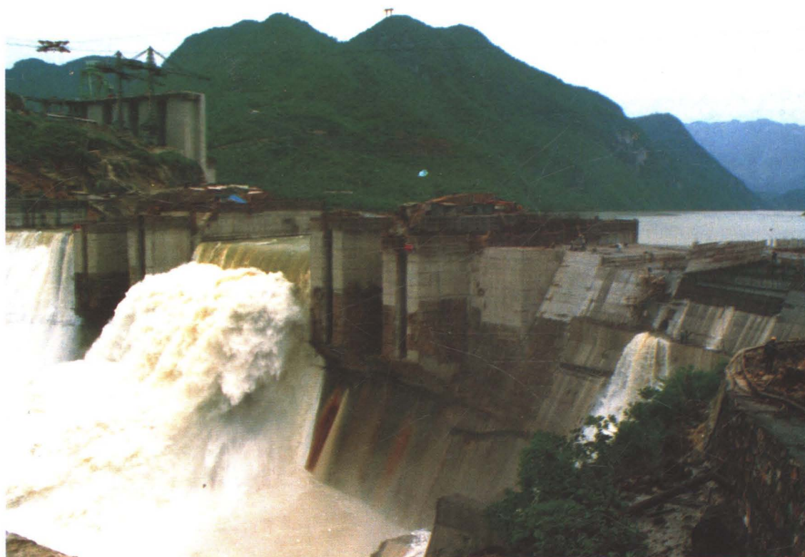
建设中的隔河岩水电站
