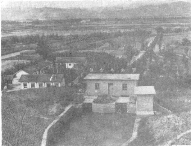
(2) 国营千惠渠河沟水电站全貌
