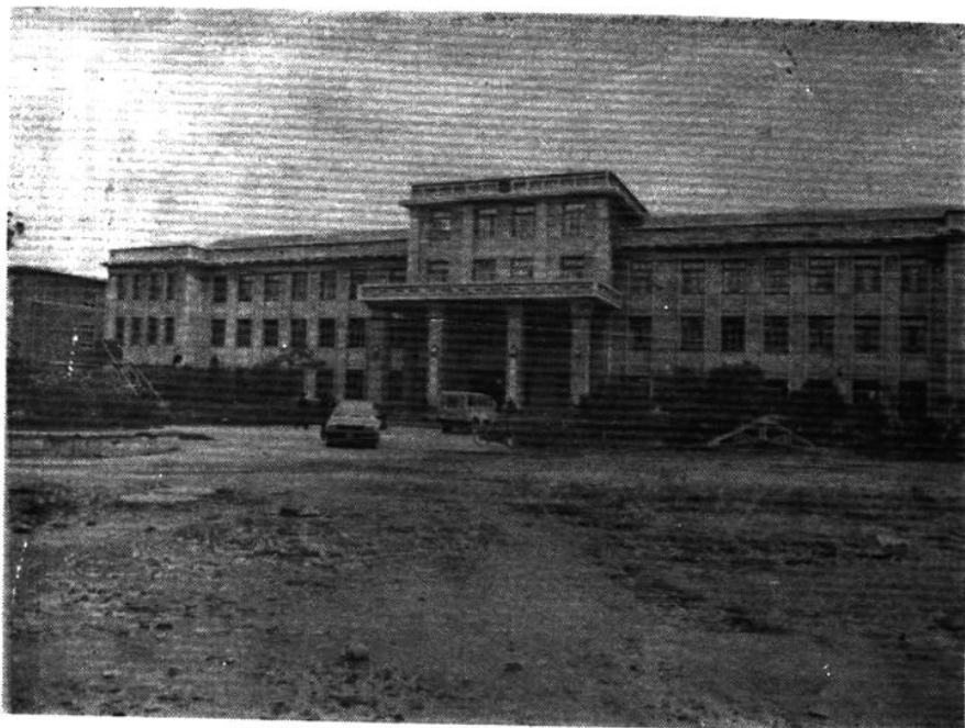
蛟河县人民政府办公楼
