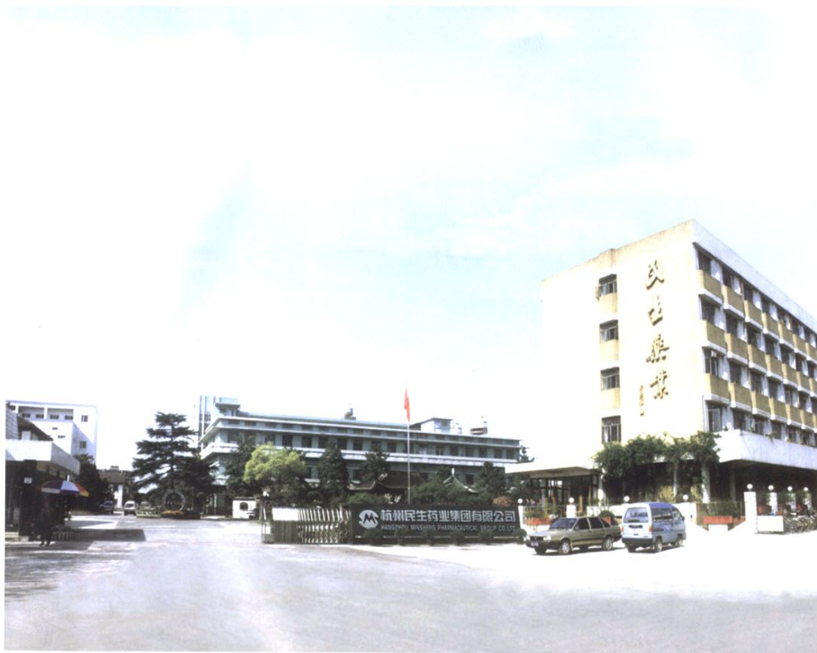
杭州民生药业集团有限公司
