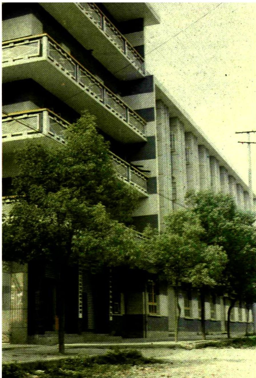
邵阳县税务局办公楼
