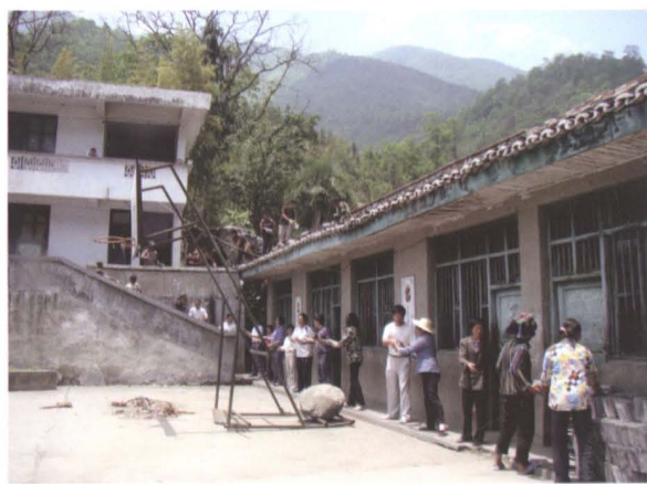
帮助群众维修受损房屋
