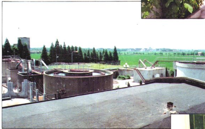
4. 5. 望新自来水厂及其水质检测室
