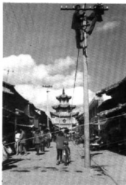
线务员在县城检修线路(1993. 1)
