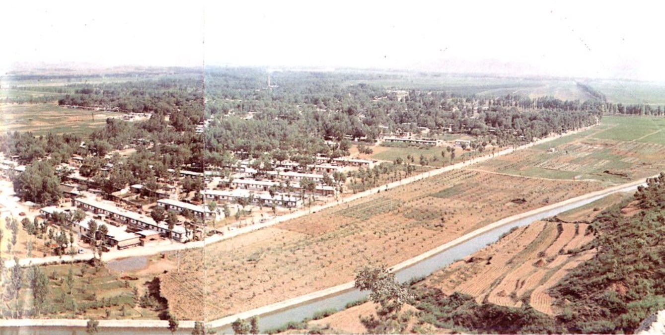
洋河水库下游万亩灌渠
