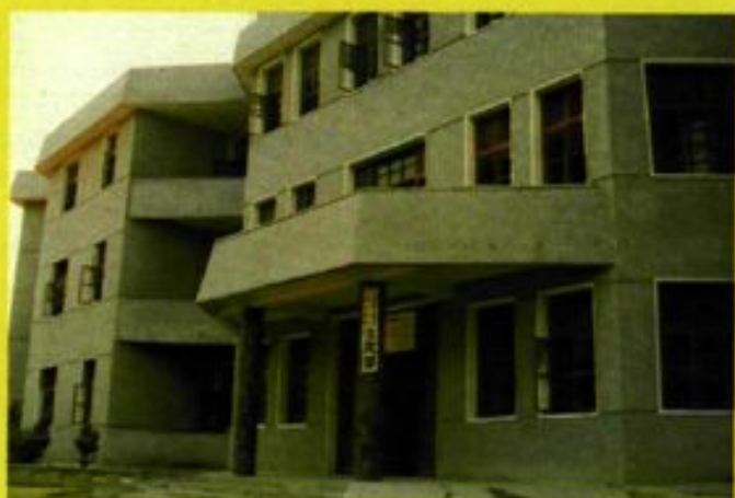
三里畝中心卫生院住院楼
