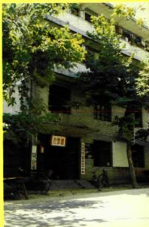
县麻风病疗养院门诊楼
