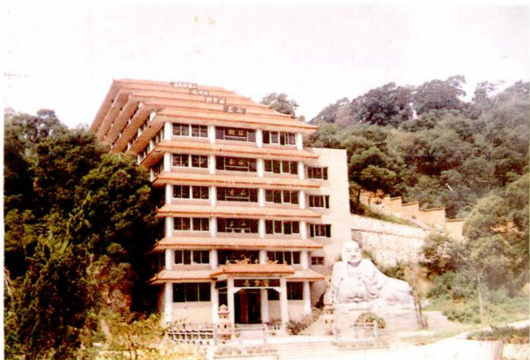
罗汉山陵园主体工程——长青堂(骨灰楼)全景
