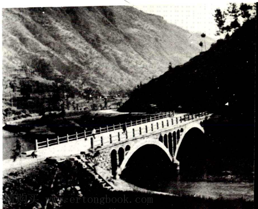
小河庙养家河大桥
