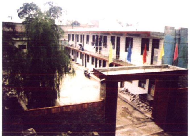
揭顶翻修美化后的村办学校。
