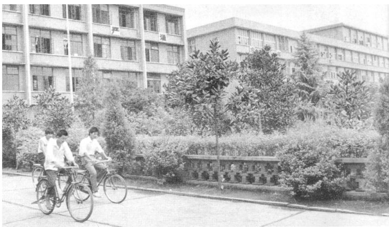
4. 县一中新建的教学大楼 (左)和实验大楼。
