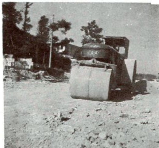
压路机碾压路面
