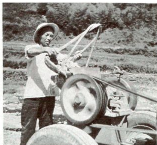
养路工人利用破碎机碾路料
