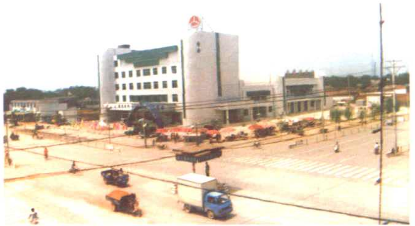
朝阳、新星交 叉路口新貌
