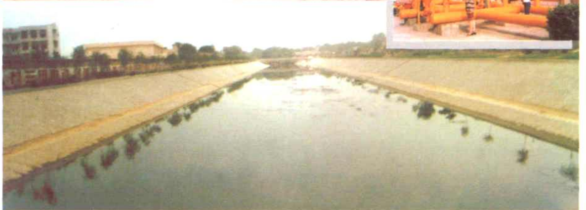
新竣工的硝河治理工程
