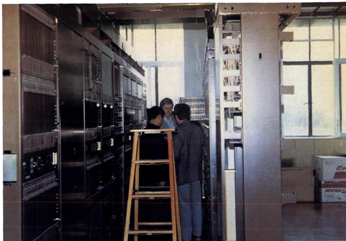
加拿大北方电讯公司在调试程控交换设备
