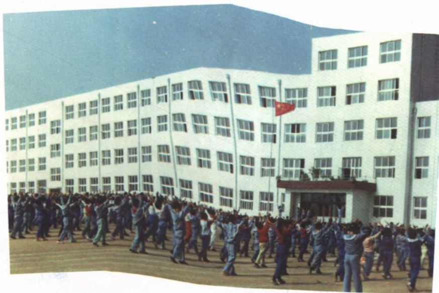
长春市双阳区通 阳小学(双阳河乡中 心小学)教学大楼 1996年建成
