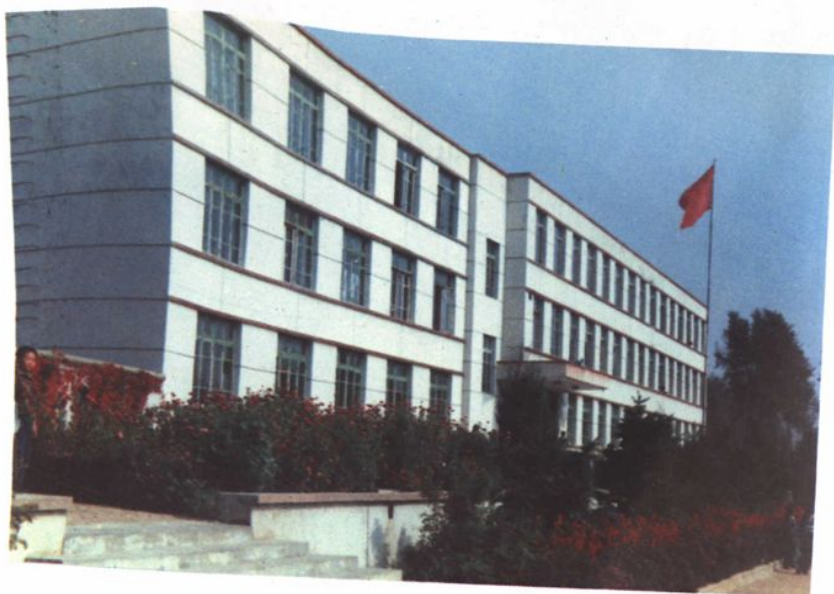
长春市双阳区奢 岭中心小学教学大楼 1991年落成
