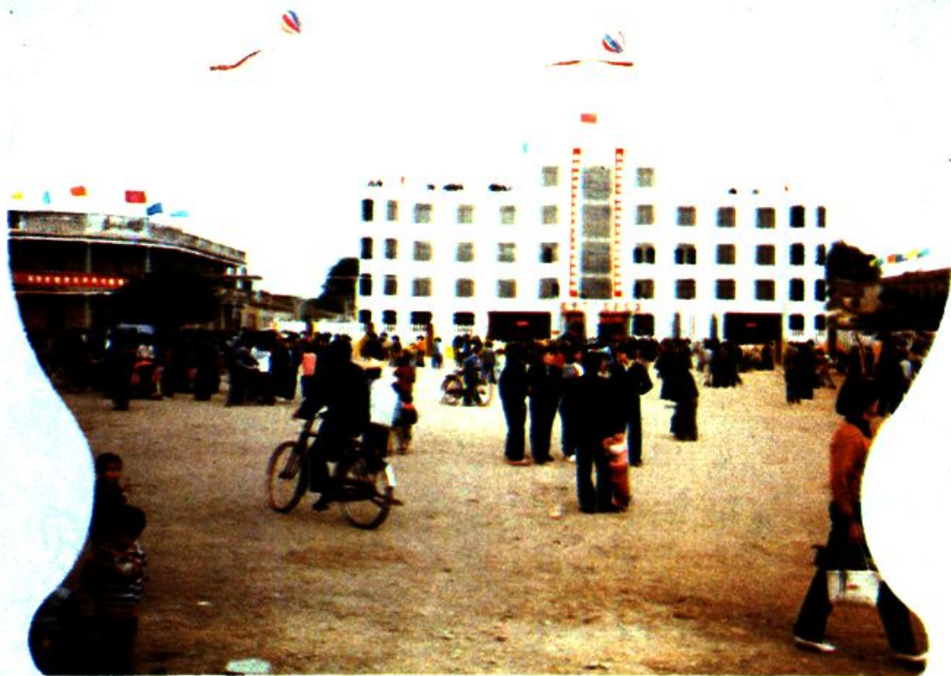
▲漳浦盐场办公科技综合大楼
