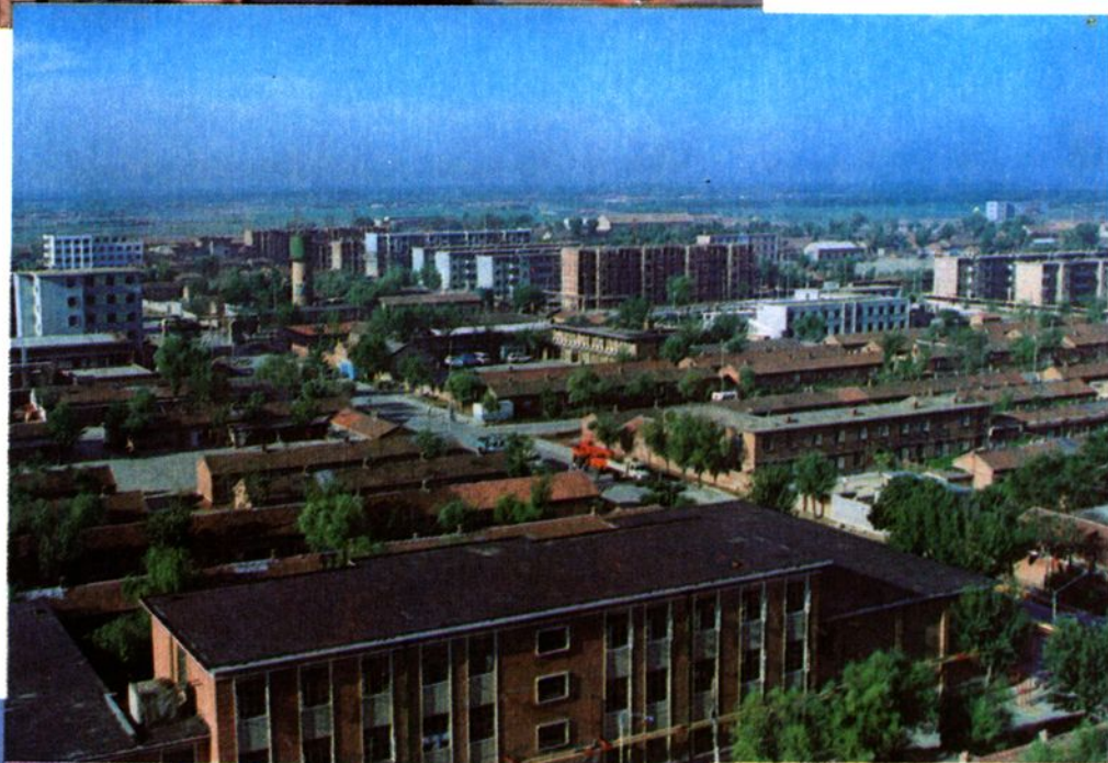
建设中的临盘
