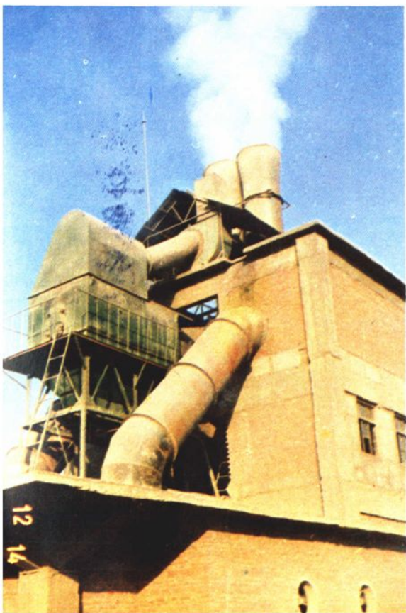
水泥生产湿法除尘冲击式沉降室▽
