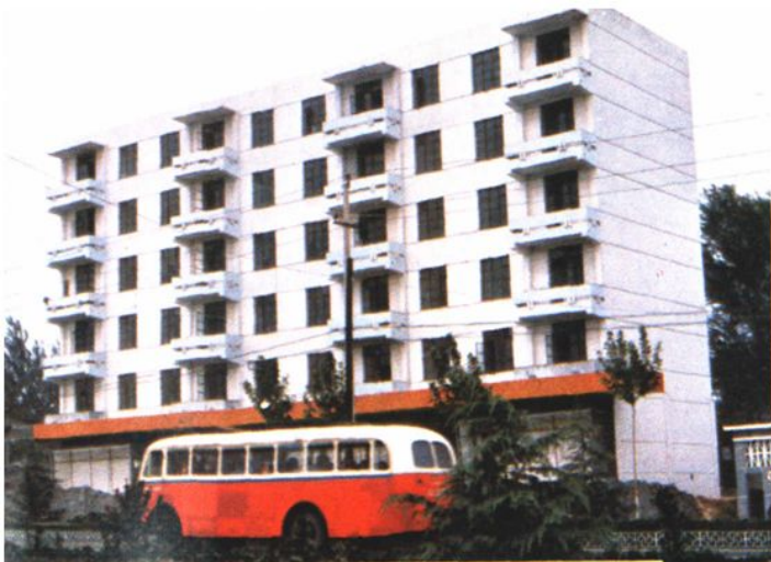
◁用粉煤灰砖兴建的工厂家属楼
