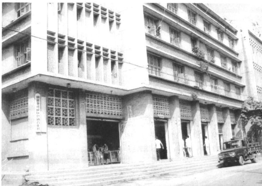
虎峰区供销社现在的门市及办公大楼
