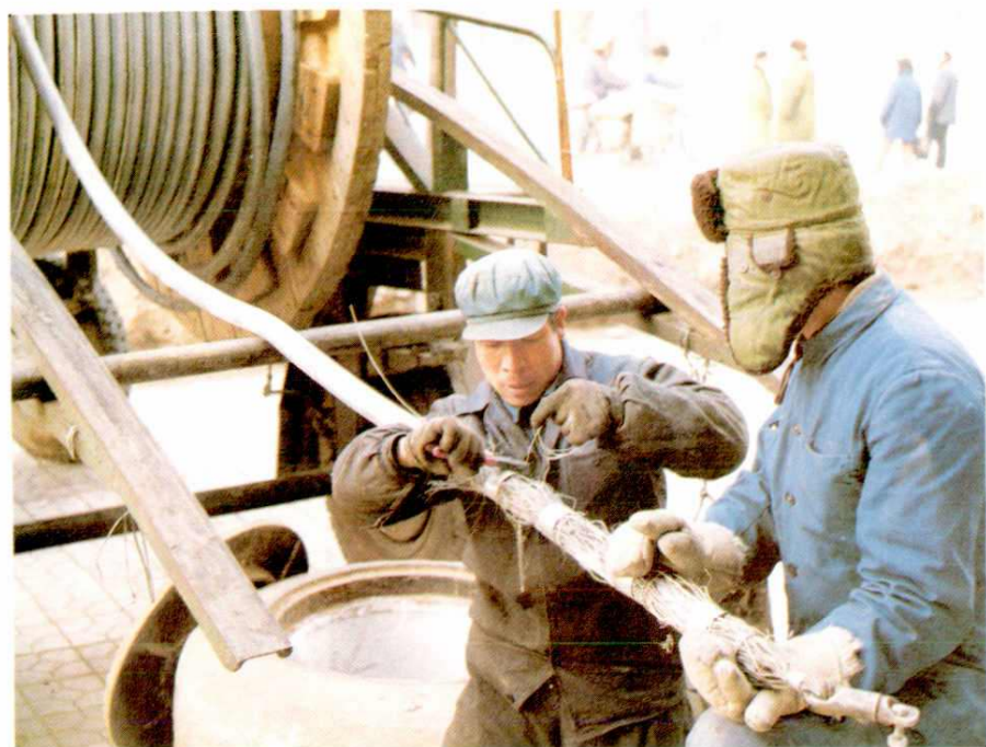
市内电话线务员铺设地下电缆
