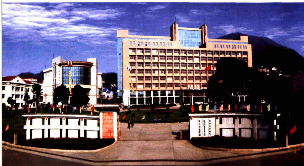
杭州钢铁集团公司。 Office complex.
