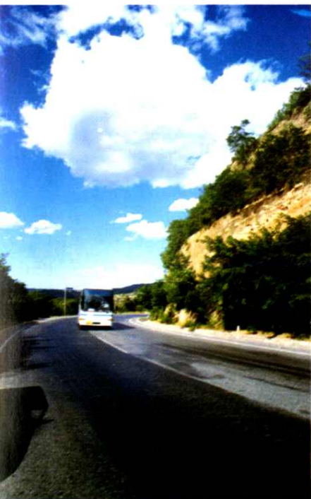
延安市境内210国道
