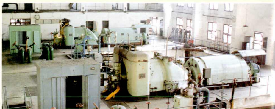
扬州发电厂老机组 ( 3 \times 1.2 万千瓦机组)
