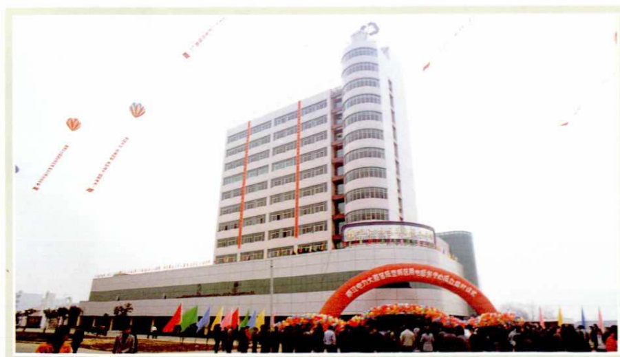
邗江县供电局办公大楼及供用电服务中心
