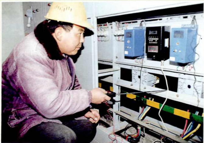
江都市供电局自行研制生产的低 压电力负荷控制器（图中黑色仪表）
