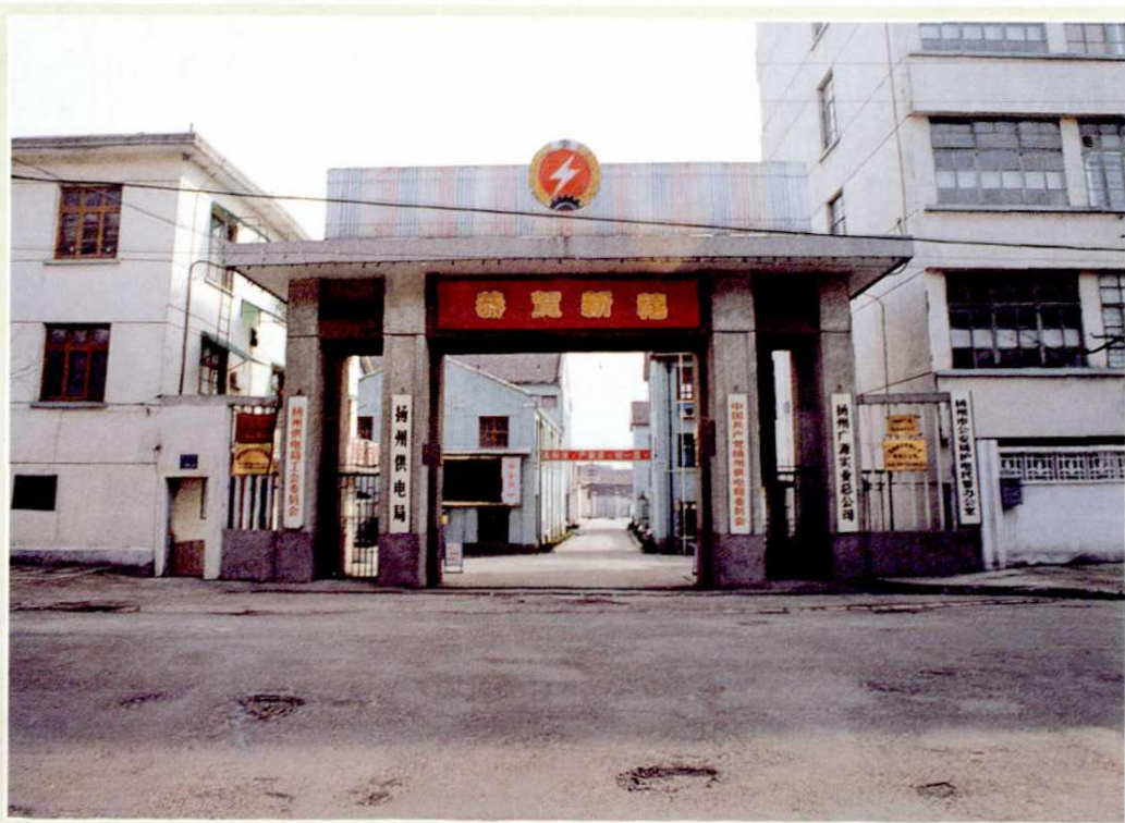
扬州供电局大门
