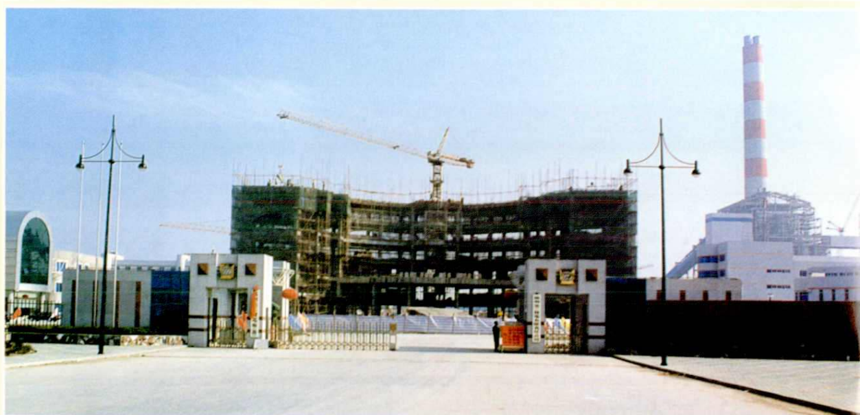
正在建设中的扬州第二发电厂 ( 2 \times 60 万千瓦)
