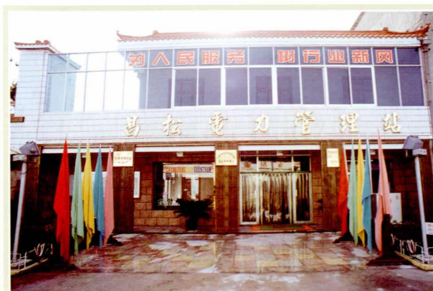
扬州供电局“为人民服务，树行业新风”乡镇电管站示范窗口——江都市昌松镇电力管理站
