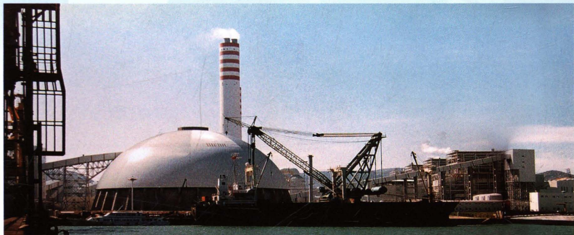
台商独资兴建的漳州后石电厂，装机6台，总容量360万千瓦。1996年7月动工，至2002年11月1~4号机组相继并网发电
