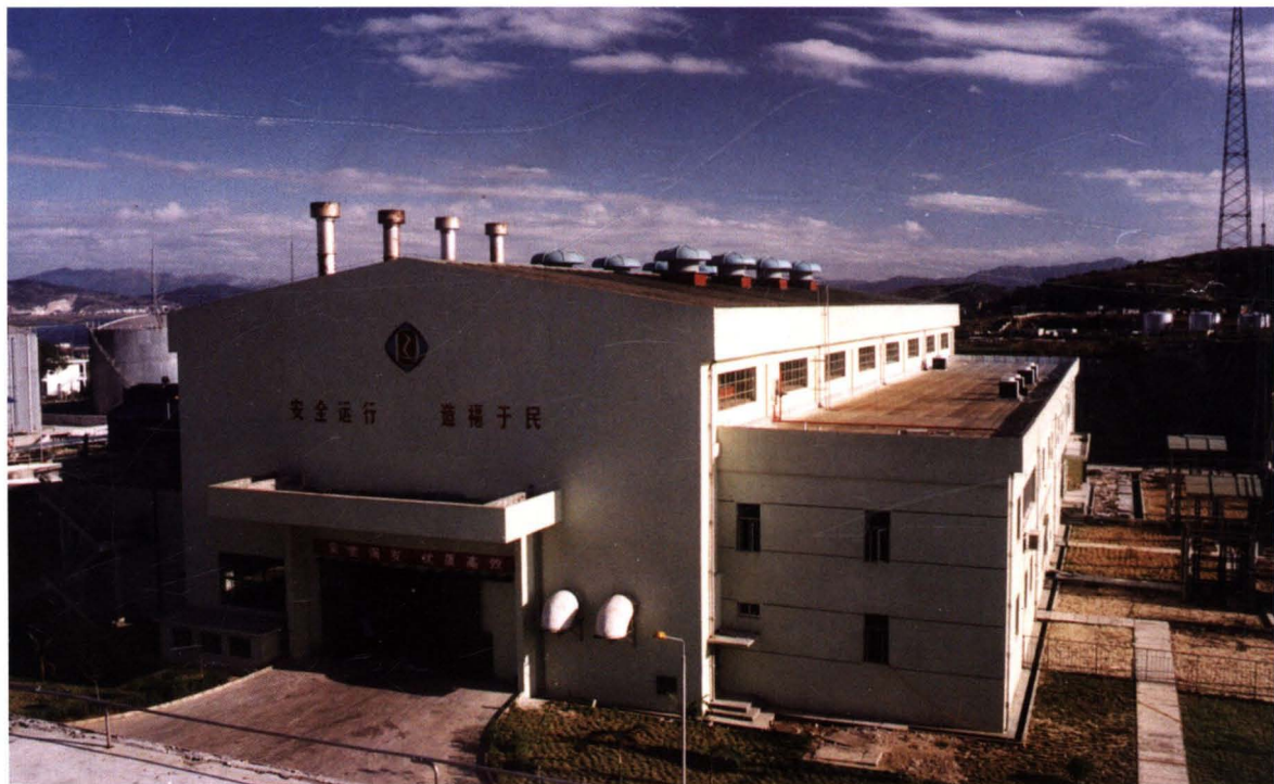
应急电源榕昌柴油机发电厂，装机6台，总容量6.912万千瓦，于1993年3月开工，至1997年6月全部投产
