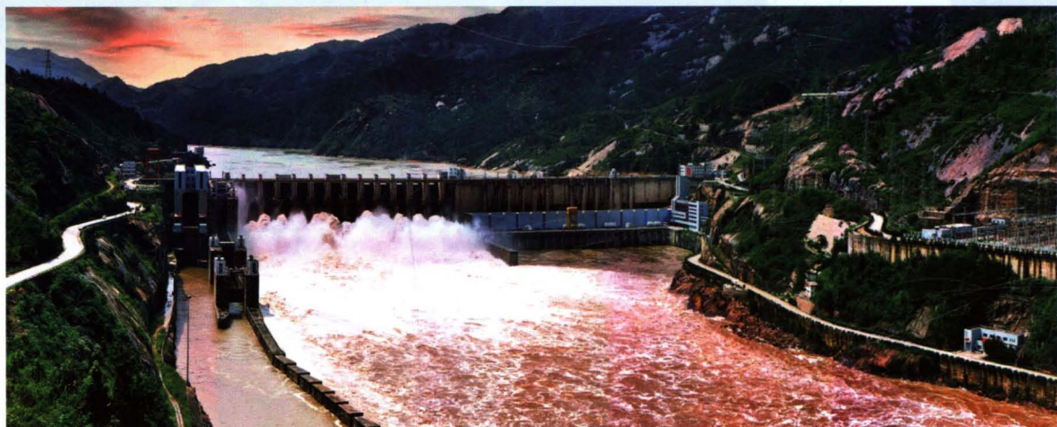
被誉为“华东第一坝”的水口水电站，装机7台，总容量140万千瓦。1987年3月开工，至1996年12月7台机组全部安装完毕并网发电
