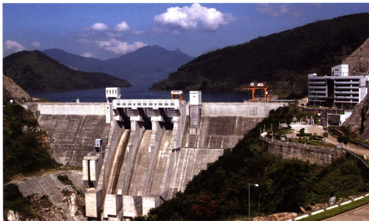
棉花滩水电站，装机4台，总容量60万千瓦。1998年3月开工，至2001年12月，4台机组全部并网发电
