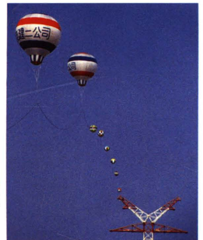
省电建二公司研制的气球索道式张力放线技术曾获电力部科技进步二等奖。2001年应用该技术进行220千伏嵩厦跨海输电线路施工
