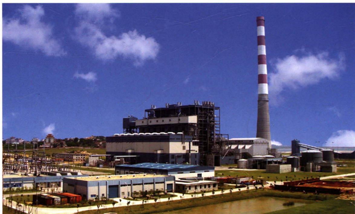
全国第一座全外资建设的湄洲湾火电厂，装机2台，总容量72.4万千瓦。1998年3月开工，至2001年3月2台机组全部并网发电
