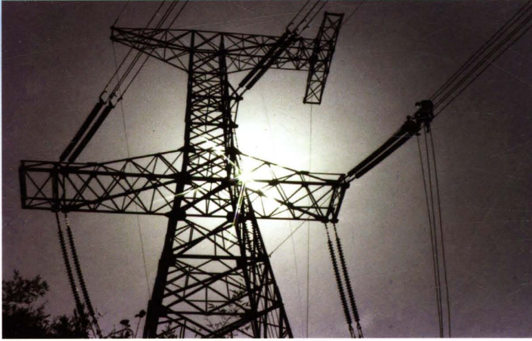
福建省第一条500千伏输电线路——水口至泉州输电线路，全长205千米，于1998年3月投运
