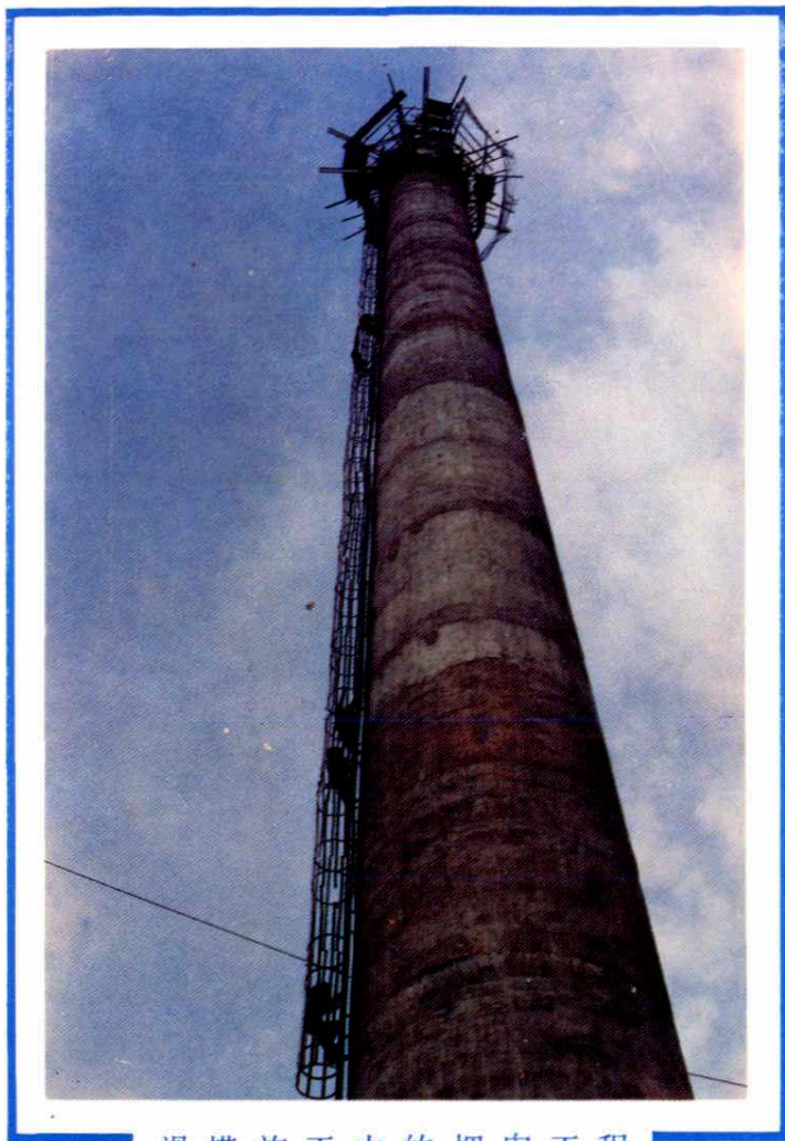
滑模施工中的烟囱工程
