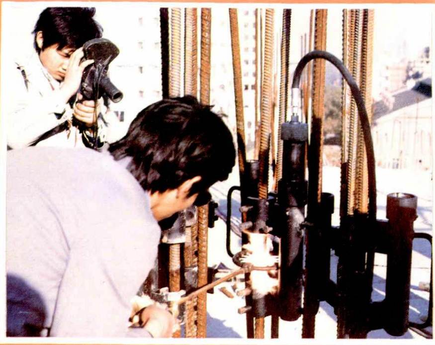
钢筋氧气压力焊
