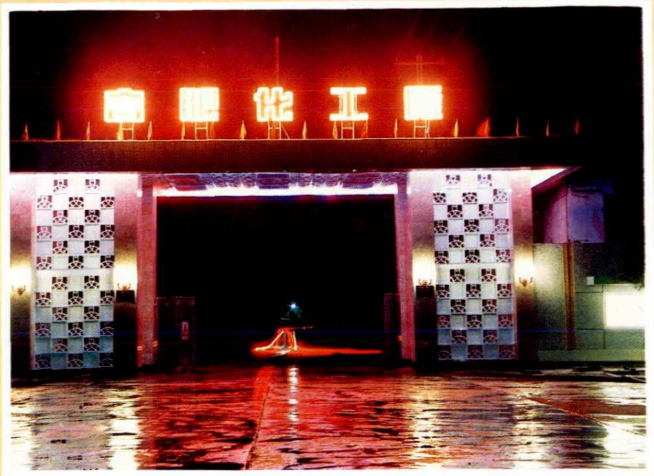
1958年5月开始建设的合肥化工厂
