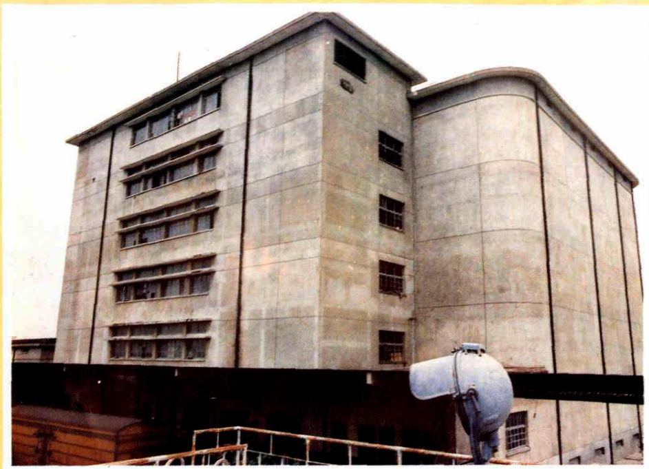
阜阳肉联厂万吨冷库 1973年5月开工，1974年12月竣工，建筑面积14072平方米。
