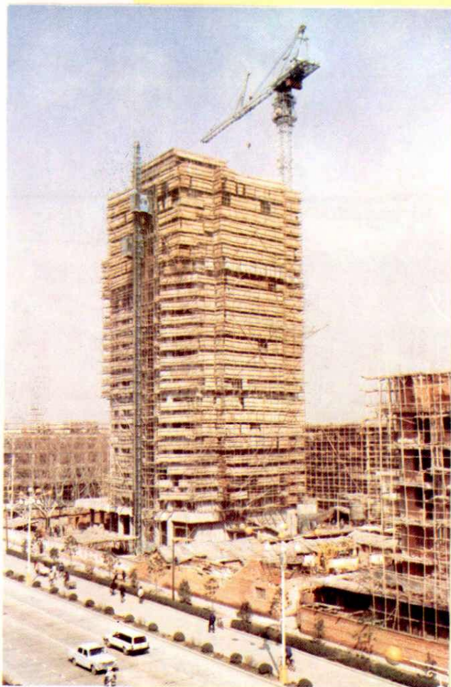
省保险公司大楼(寿春路 28 号楼) 1987 年 9 月 开工 17 层框架结构 建筑面积 8483 平方米
