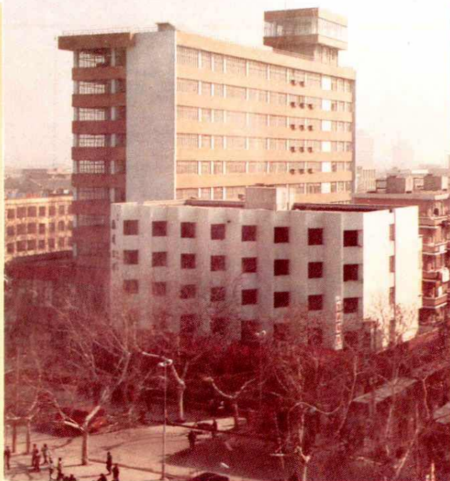
省劳动服务公司大楼，1984年6月开工，建筑面积12271平方米。
