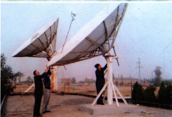
▲ 地面卫星接收设施
