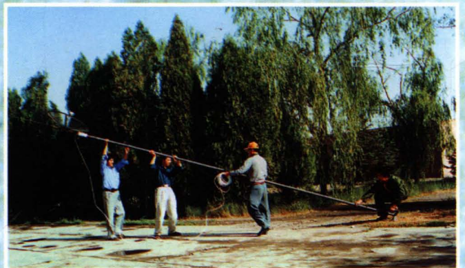
▲ 农村多路微波有线电视建设现场
