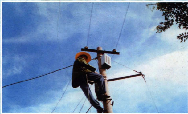
▲ 工程技术人员安装定频音箱
