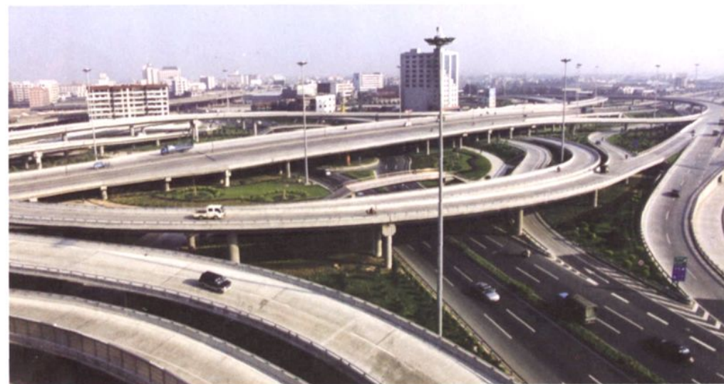
广佛高速公路 谢边立体交叉
