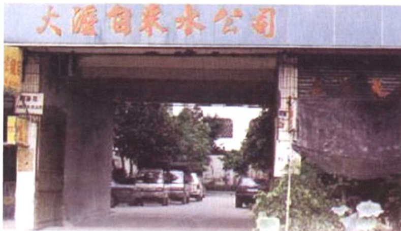
1990 年，设立大沥自来水公司， 与桂城水厂、县二水厂联网， 日均供水量达 8 万立方米。
