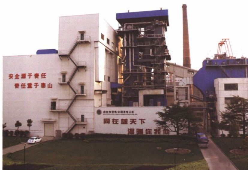
启东蓝天热电公司主厂房和办公楼
