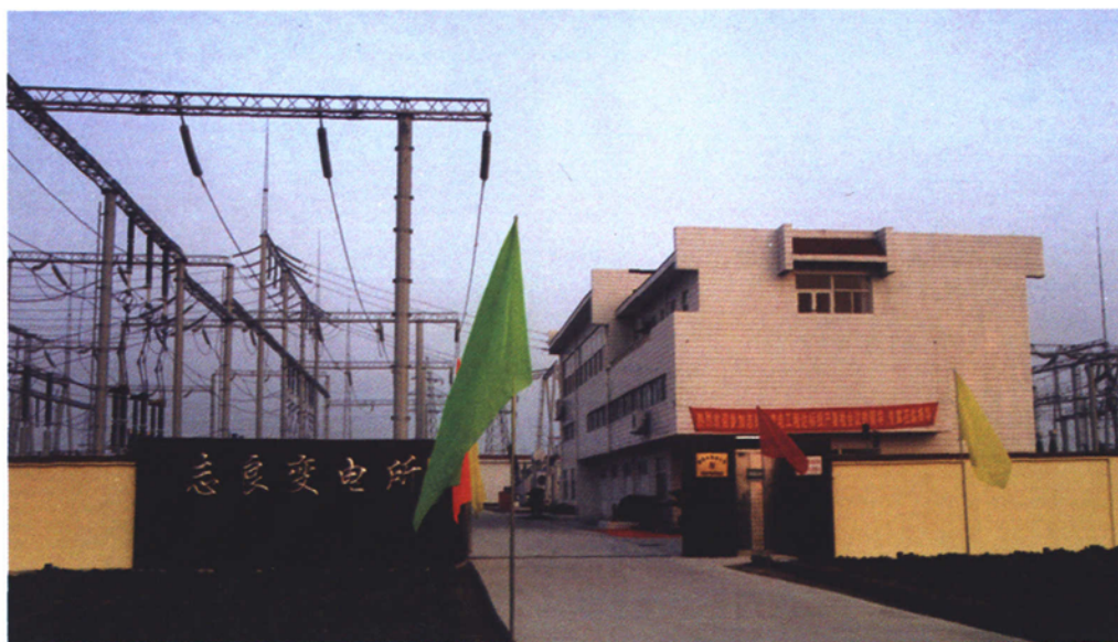
2001年12月24日建成投运的220千伏志良变电所
