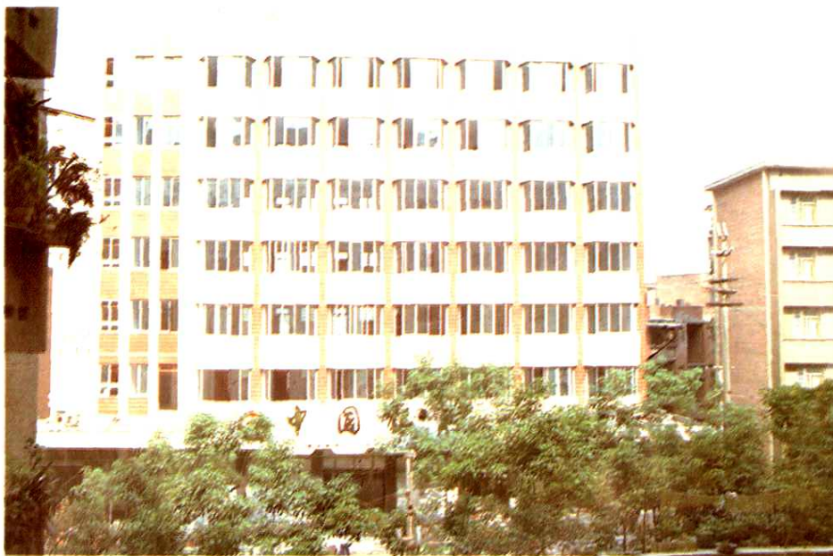
中国银行内江市分行办公大楼
