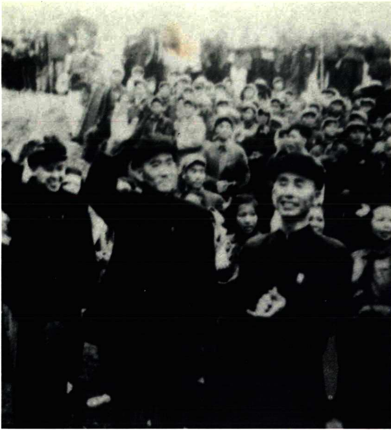
1959年元旦，中共广西壮族自治区委员会第一书记刘建勋（前排中）、区人民委员会主席韦国清（前排左）参加渠黎——东罗铁路专用线通车典礼
