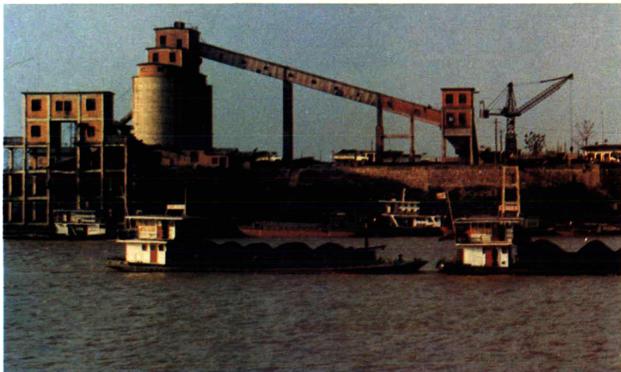
那龙煤矿煤仓码头
