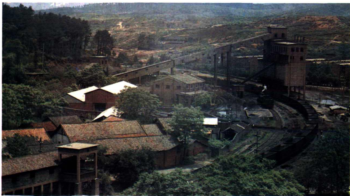
广西最大矿井——年产 60 万吨的东矿斜井
