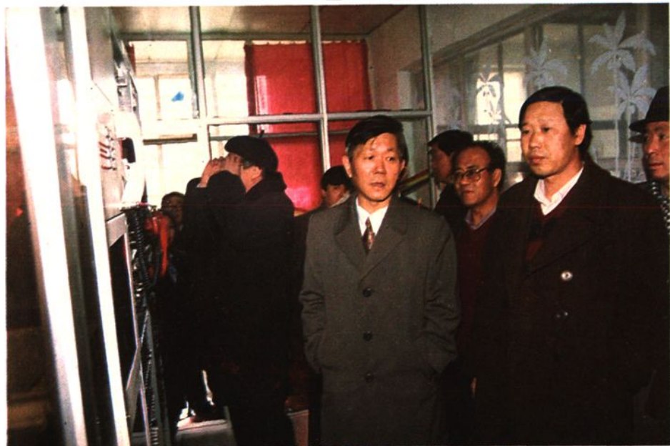
内蒙古自治区邮电管理局局长张春生(中)等领导视察赤峰松山区农村支局机房
