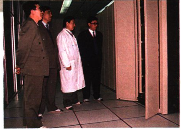
市局局长齐志国视察程控机房
