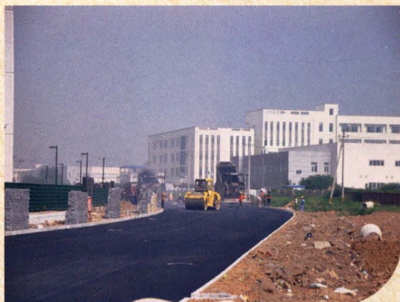
常营地区建设中的市政道路
