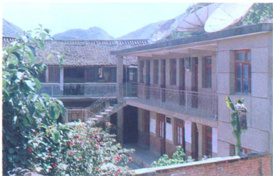
习谦村办公楼
