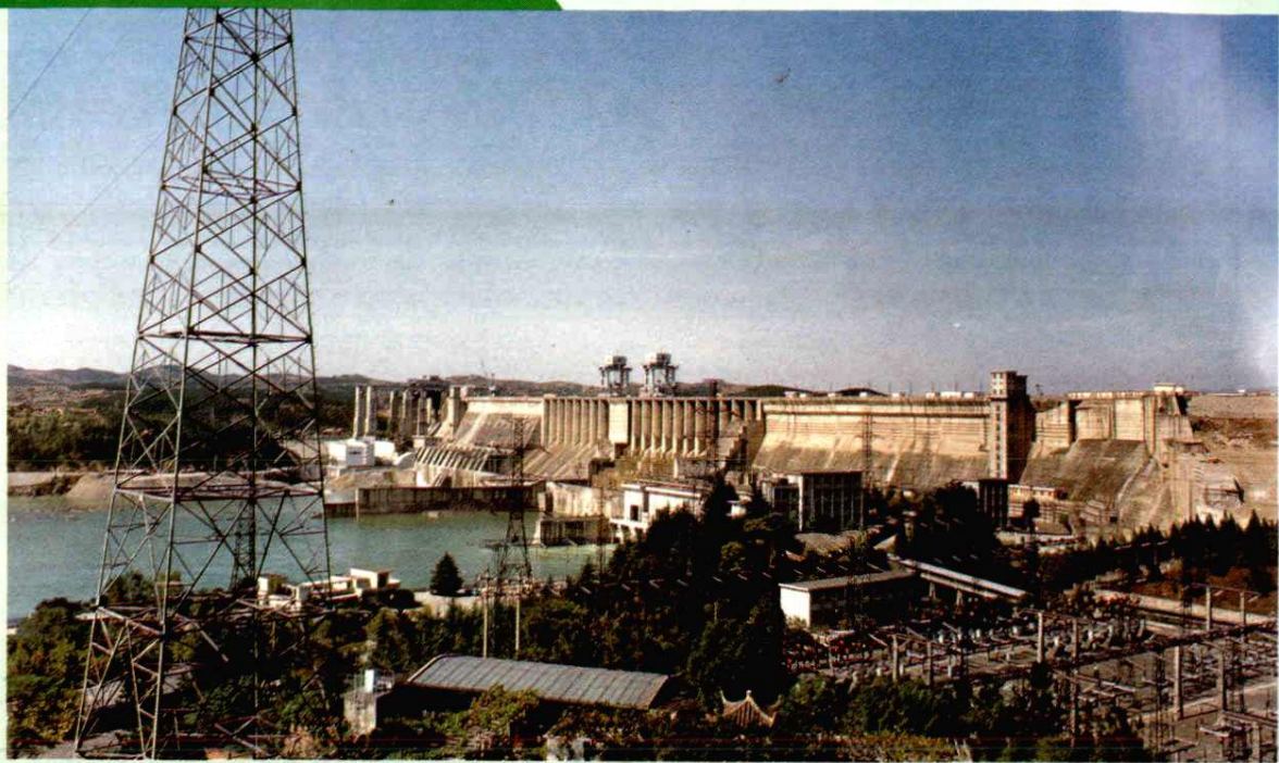
丹江口水电厂安装 6 \times 15 万千瓦发电机组, 总容量 90 万千瓦, 1968 年 10 月第 1 台机组并网发电
