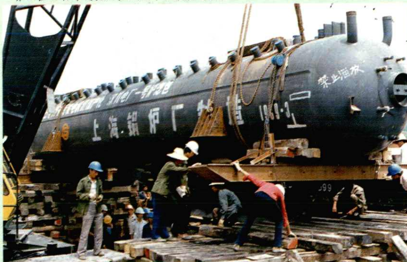
建设中的汉川电厂锅炉安装现场
