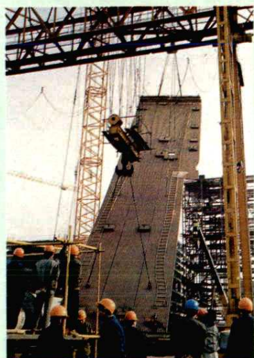
阳逻电厂锅炉水冷壁起吊
