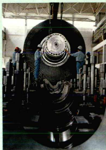
阳逻电厂汽轮机安装
