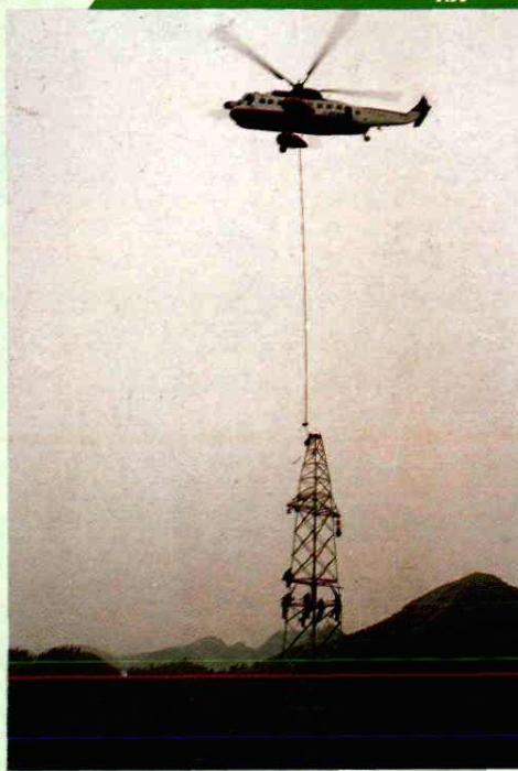
1985年湖北省输变电工程公司 首次租用直升飞机吊装铁塔
