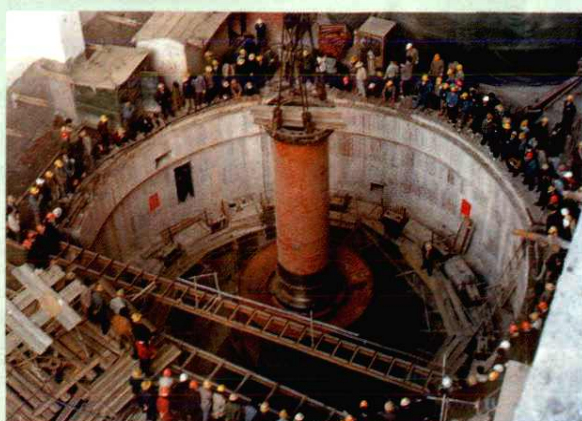
隔河岩水电厂装机容量 120 万千瓦, 图为发电机大轴吊装
