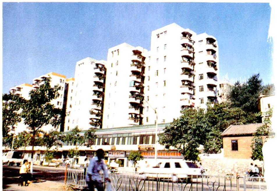
广州重型机械厂综合楼，高10层，由三个塔楼组成，建筑面积5800多平方米，由湛江市第四建筑工程公司承建
