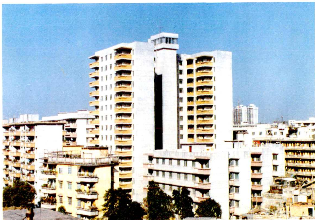
广州军区政治部干休所师职住宅楼，由吴川县兰石建筑公司施工，高17层，建筑面积11380平方米，广东省优良样板工程
