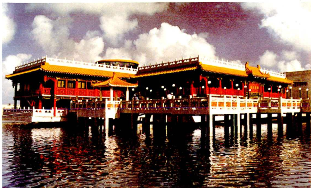
湛江画舫，座落在湛江市霞山海滨公园海上，由湛江市建筑水电工程公司施工
