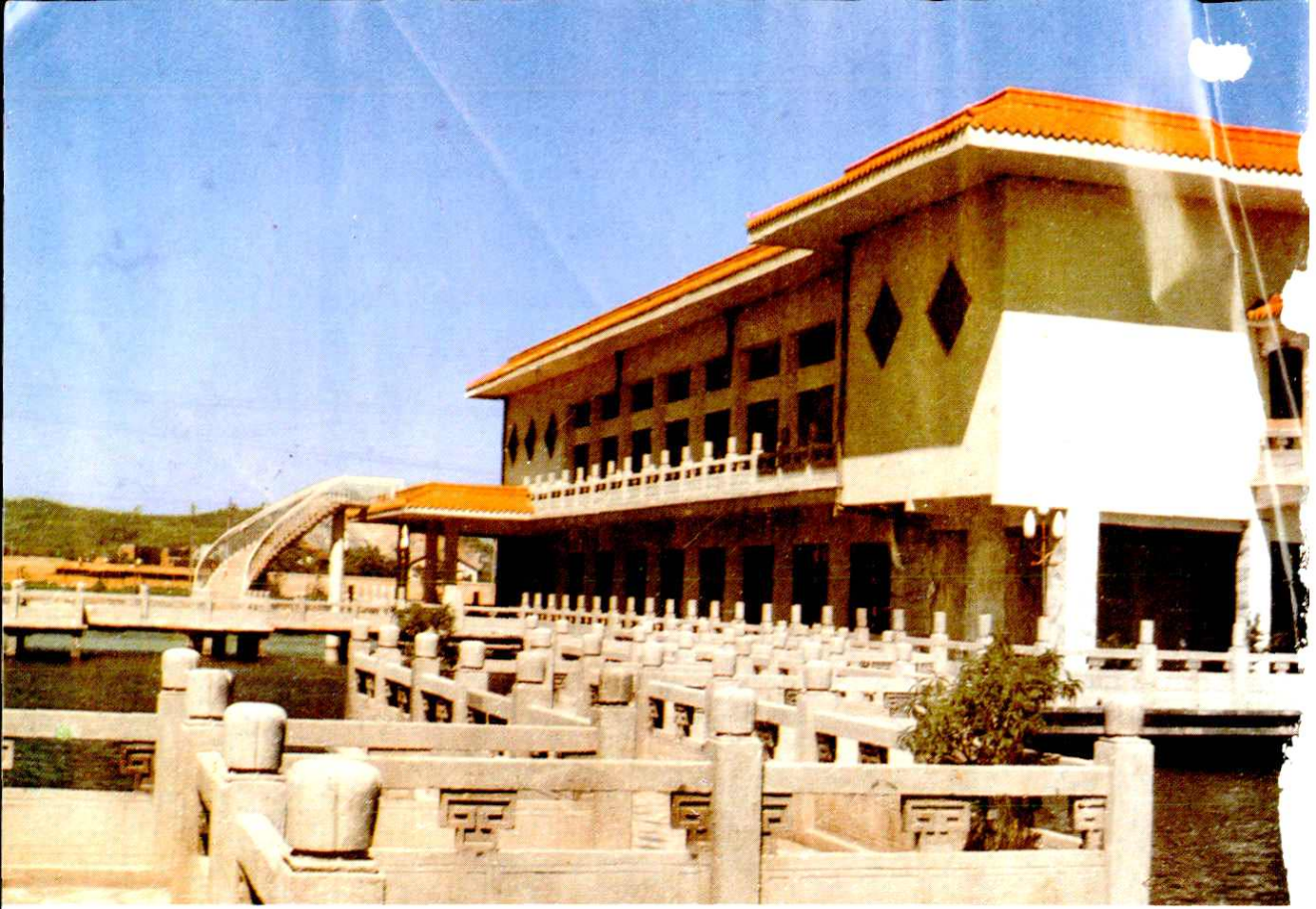
湖北省襄樊市南湖宾馆，由湛江市第七建筑工程公司施工，建筑面积1.6万平方米，宾馆会议厅和3号楼为全优工程
