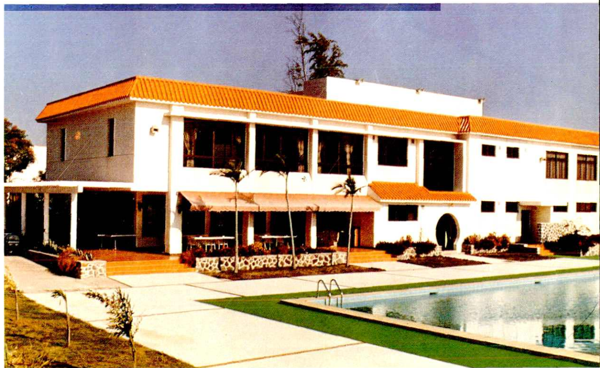
湛江海滨宾馆畔海楼，由吴川县兰石建筑工程公司施工，广东省建委评为全优样板工程
