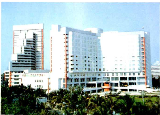
◀海口金融商业大厦，由湛江市第二建筑工程公司施工，金融大厦高24层，商业大厦高14层，总建筑面积8万多平方米
