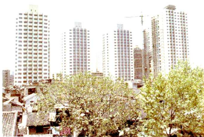
◀上海朱家湾高层住宅楼，由广东省八建承建，共6幢，其中20层高的4幢，25层高的2幢，并有商场、幼儿园等配套工程，总建筑面积74020平方米
