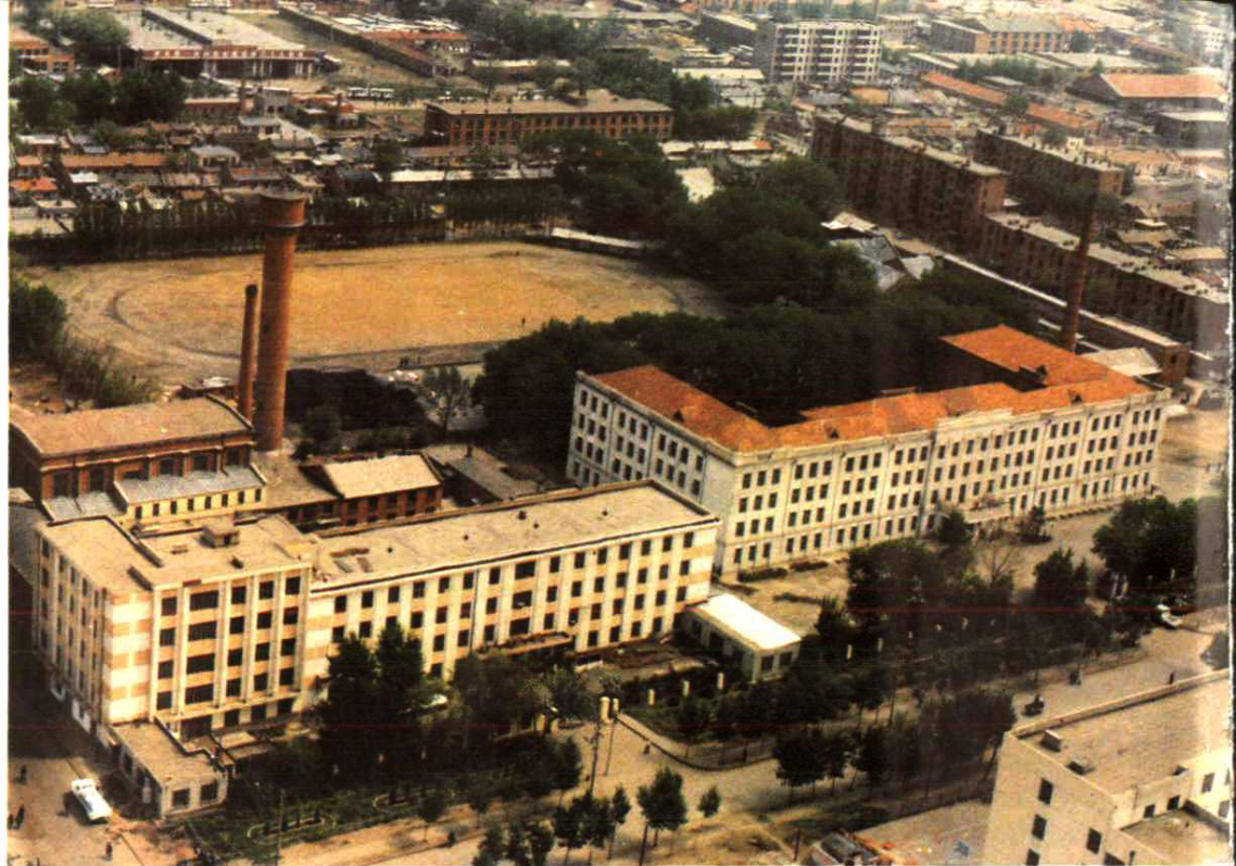
△哈尔滨电力学校全貌
