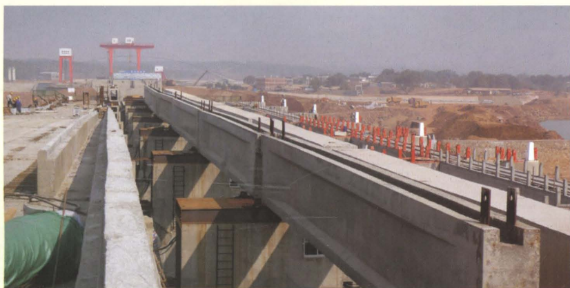
建设中的省重点建设工程——石虎塘航电枢纽
