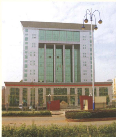
县烟草专卖局办公大楼
