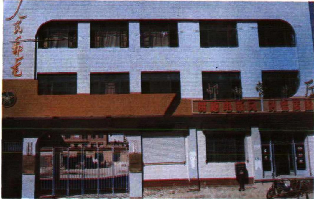
1955年，建成的库伦旗邮政综合楼
