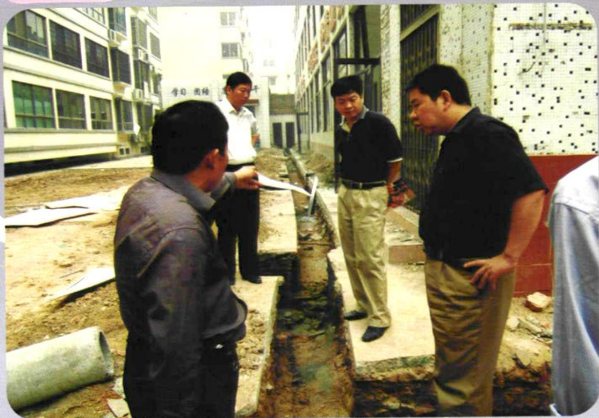
街道党工委书记郑向阳视察办公楼改造工程
